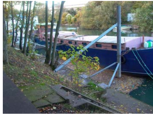
Exemple d'amarrage avant aménagement
