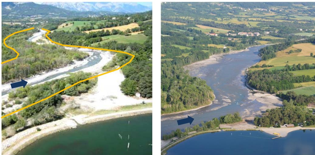
Figure 2 : Le Drac, avant et après travaux au droit de la base de loisirs du Plan d'eau du Champsaur (©CLEDA)
