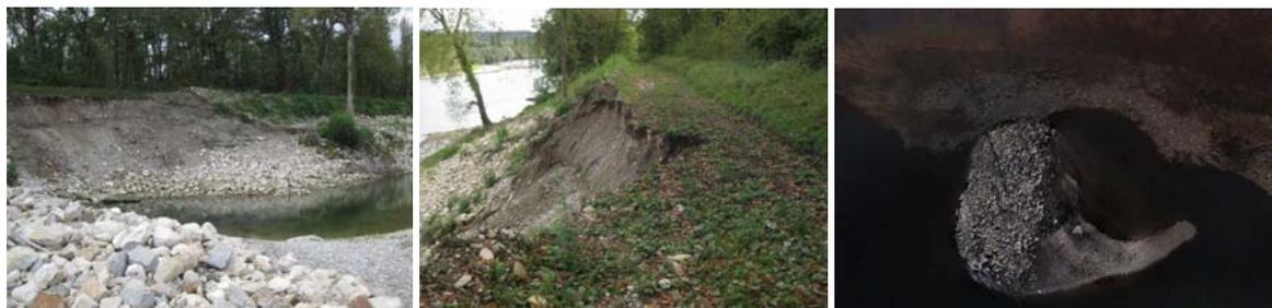
Figure 1 (a, b, c). Encoche d'érosion à l'amont du site (a, b) et langue de dépôt à l'aval (c)
