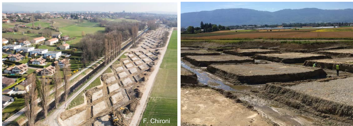
Fig. 4 Vue d'ensemble (mars 2014) et détail (juillet 2014) des terrassements avant les 1ères crues.
