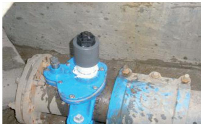
Sonde Kapta permettant la mesure de différents paramètres qualité en continu
