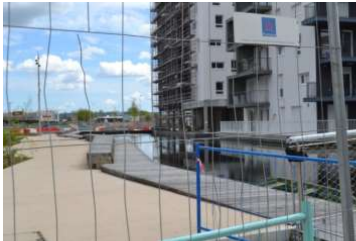
Figure 66 : Le canal nord – photo : S. Baati, 2013
