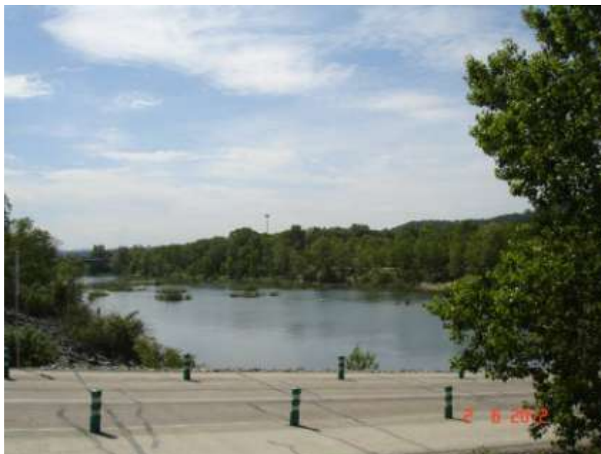
Figure 31, Le seuil fixe construit à l'aval du lac des Eaux Bleues © Ziad Kachachi
