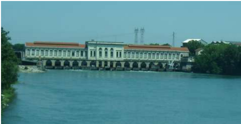
Figure 24. La centrale hydroélectrique de Cusset, © Ziad Kachachi
