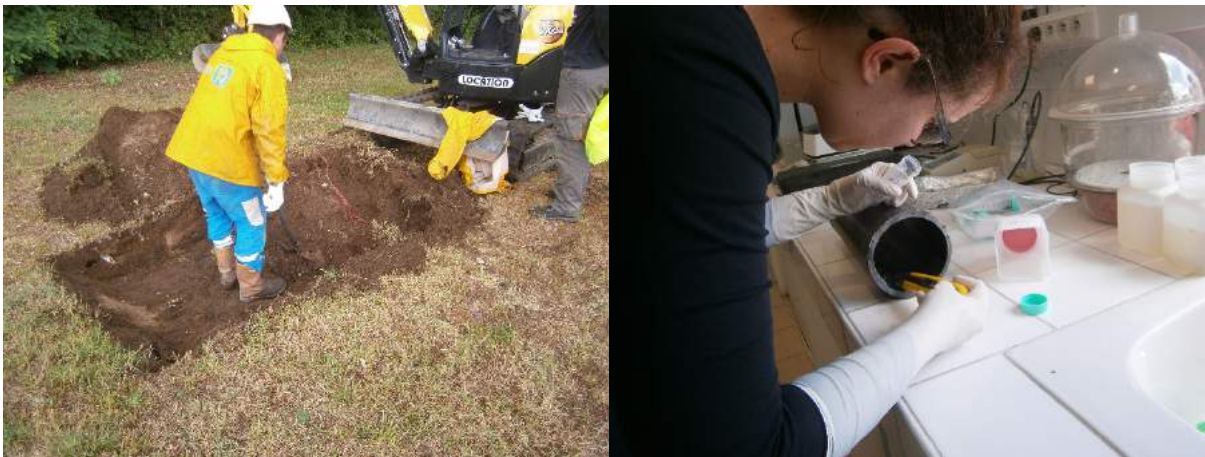
Figure 4 : Creusement d'une tranchée et prélèvement de biofilm dans la portion de tuyau excavé.
