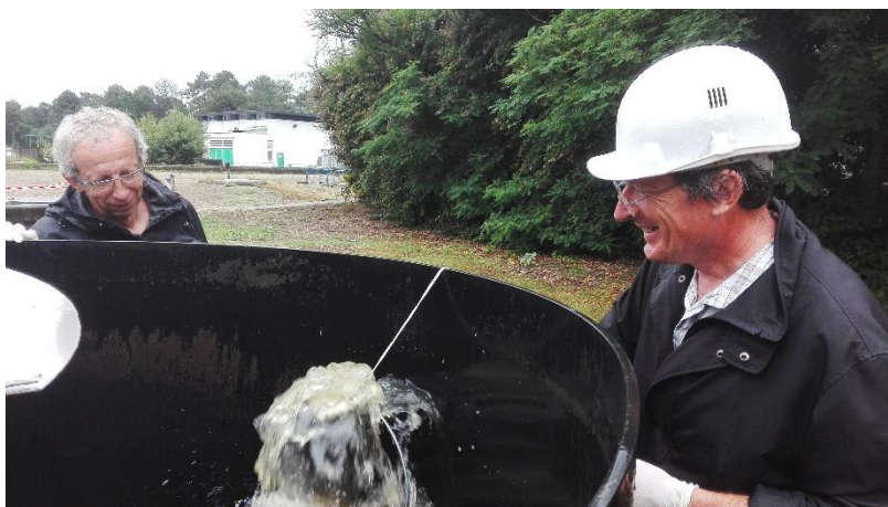
Photo 2 : Arrivée des eaux usées du PSA à l'exutoire de la conduite de refoulement.
