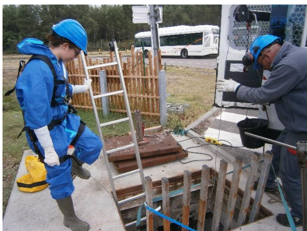
Photo 8 : Prélèvement de biofilm amont dans la bache de la station de pompage.
