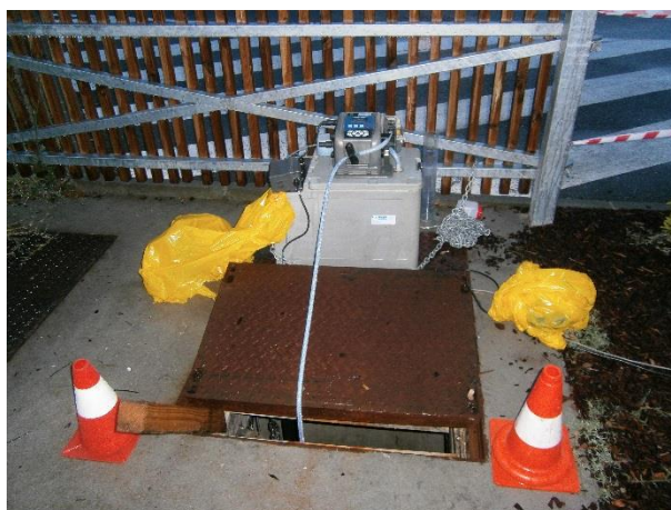
Photo 1 : Prélèvements dans la bache de la station de pompage du PSA en amont de la conduite de refoulement.
