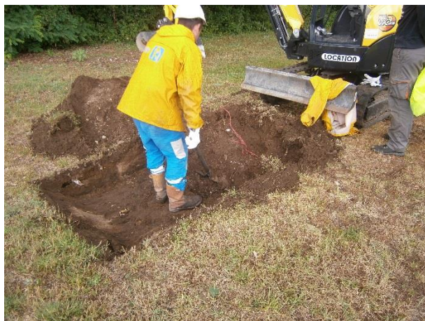
Photo 9 : Creusement d'une tranchée pour la collecte d'un échantillon de biofilm à l'aval de la conduite de refoulement.
