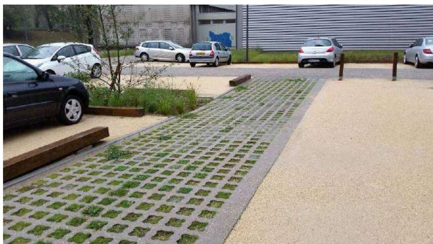
Il existe un très grand nombre de revêtement poreux ou perméables ; dans ce cas, l'aménageur a utilisé des pavés en béton discontinus suffisamment résistants pour que cette allée soit accessible aux véhicules de service et de secours.
