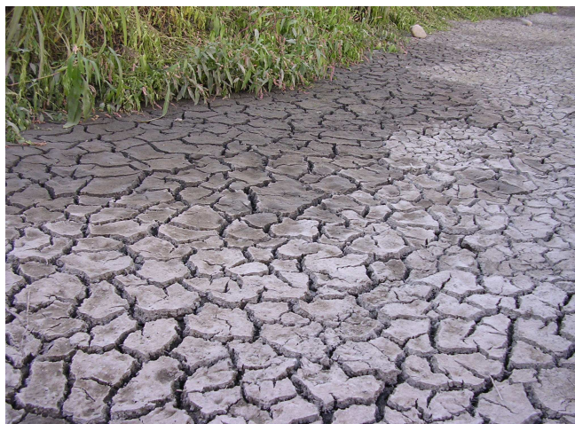
Figure 1 : Photo de la surface du bassin d'infiltration Django Reinhardt durant un séchage
