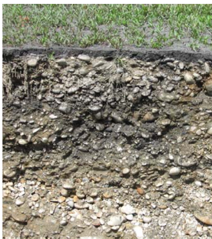
Figure 2 : Exemple de coupe de sol en fond du bassin d'infiltration de Django Reinhardt (Chassieu). On voit nettement une couche noire de surface dont la granulométrie est fine. Cette couche se retrouve sur tous les bassins du même type.
