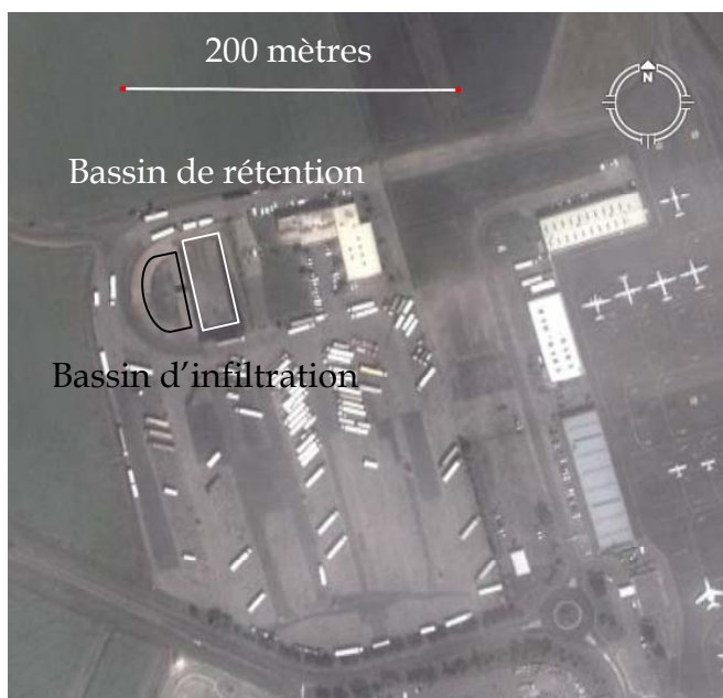
Figure 2 : Site du Centre Routier : ouvrage et bassin versant (photo Google Earth)
