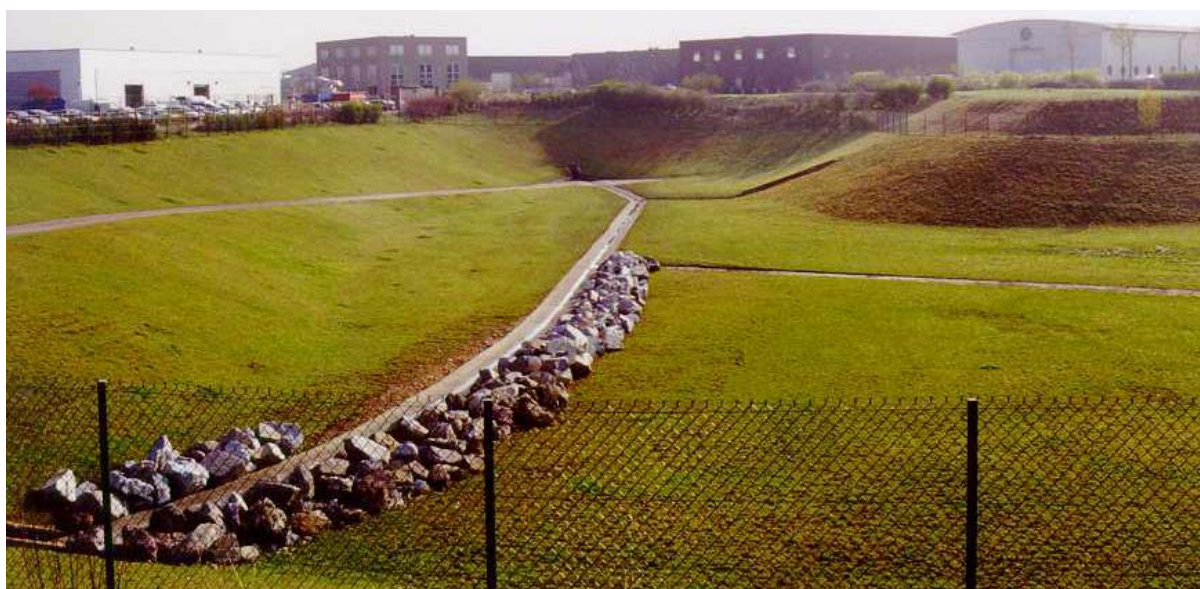
Figure 1 : Vue du bassin de rétention de ZAC du chêne.
