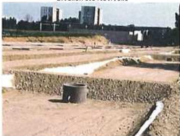
Pose du drain sur géomembrane
