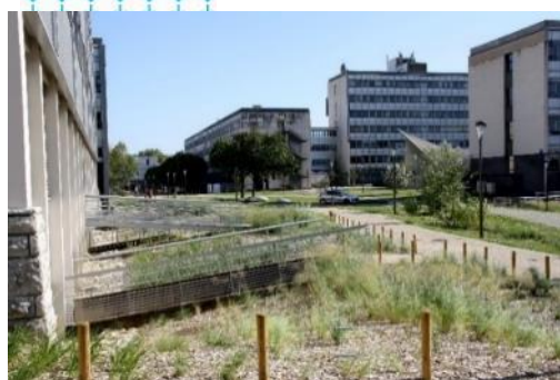
D. Tranchée d'infiltration au pied d'un bâtiment
