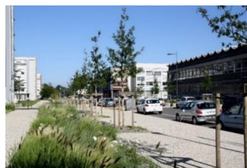
C. Tranchée d'infiltration en bord de voirie
