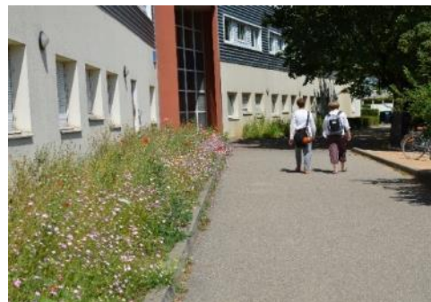
Tranchée d'infiltration plantée au pied d'un bâtiment
