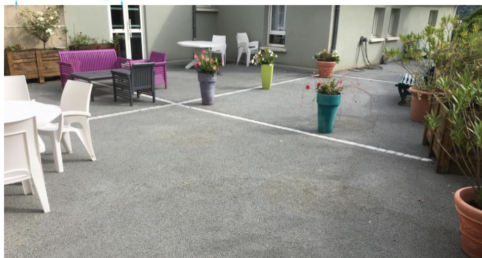
Terrasse revêtue du béton drainant
