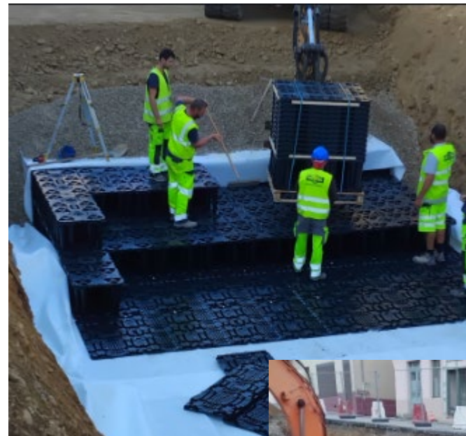
2024 pose d'un bassin d'infiltration à St Sorlin en Valloire (travaux de déconnexion/infiltration)
