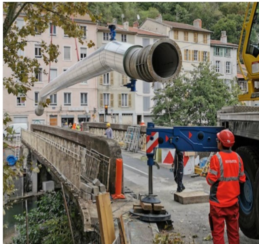
Sept 2019 dernier tronçon conduite Bonna à Vienne (travaux d'économie d'eau)
