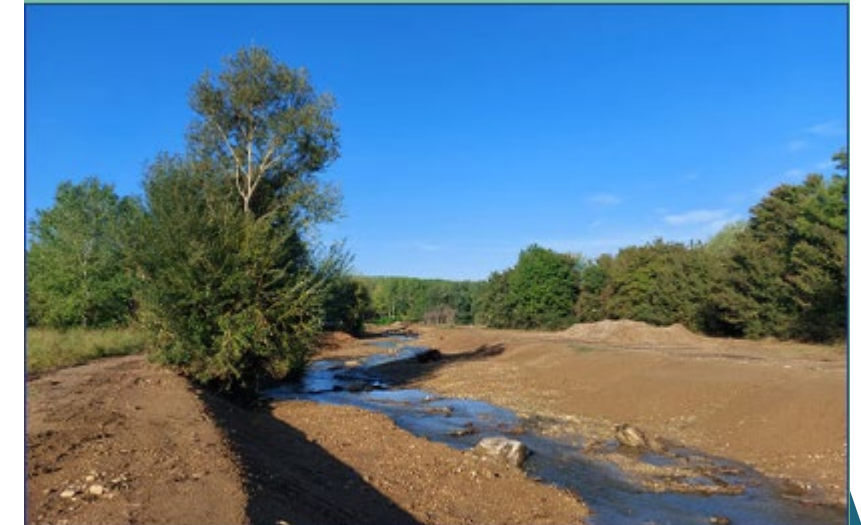
Après les travaux de terrassement
