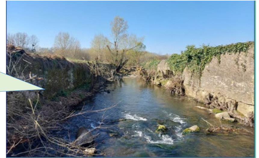
Avant les travaux de terrassement
