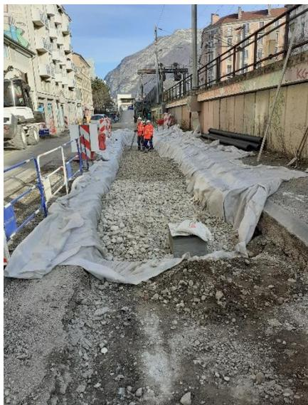
A gauche : réalisation du massif infiltrant sous les stationnements imperméables
