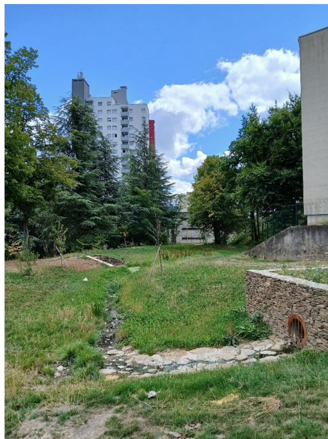
Bassin sec : vue de l'arrivée des eaux pluviales (à droite) et de l'exutoire (à gauche)
