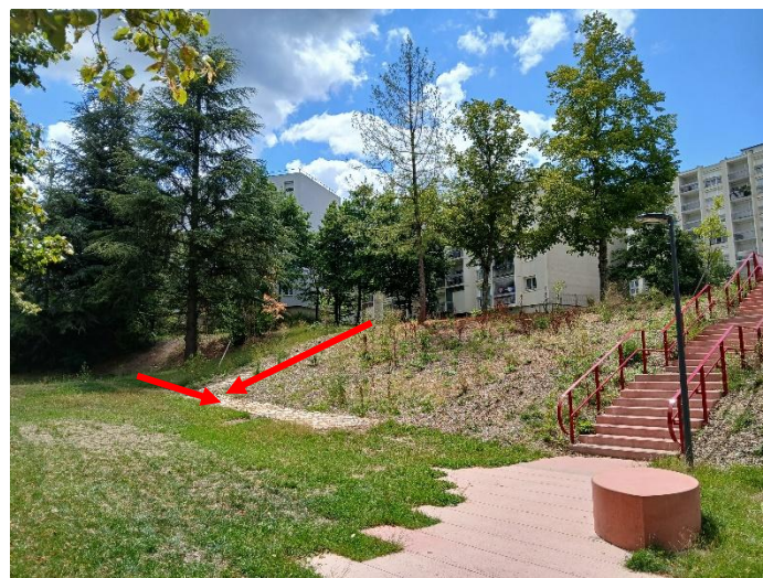
Exutoire surverses des 2 bassins (parcours de moindre dommage)
