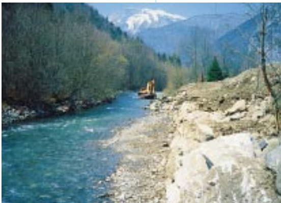
Chantier de mise en œuvre d'une protection des berges.
