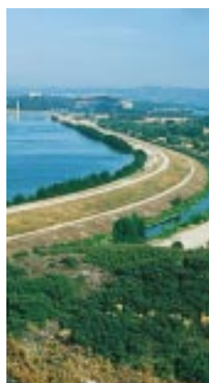
Digue de protection contre les inondations (vallée du Rhône).
