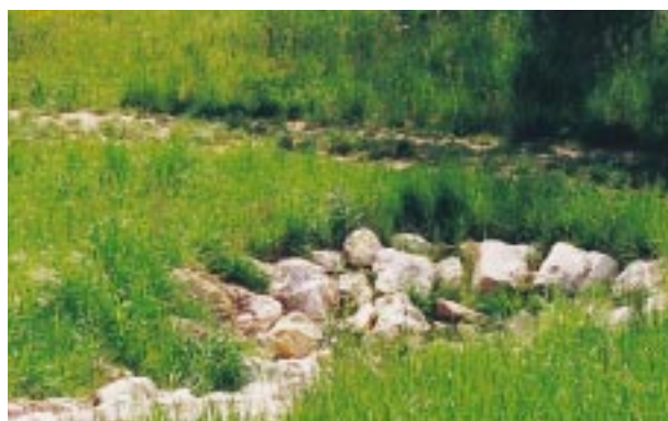
Dispositif d'infiltration des eaux de ruissellement.
