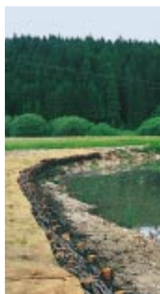
Travaux de protection de berge par technique végétale (Drueon, Jura).
