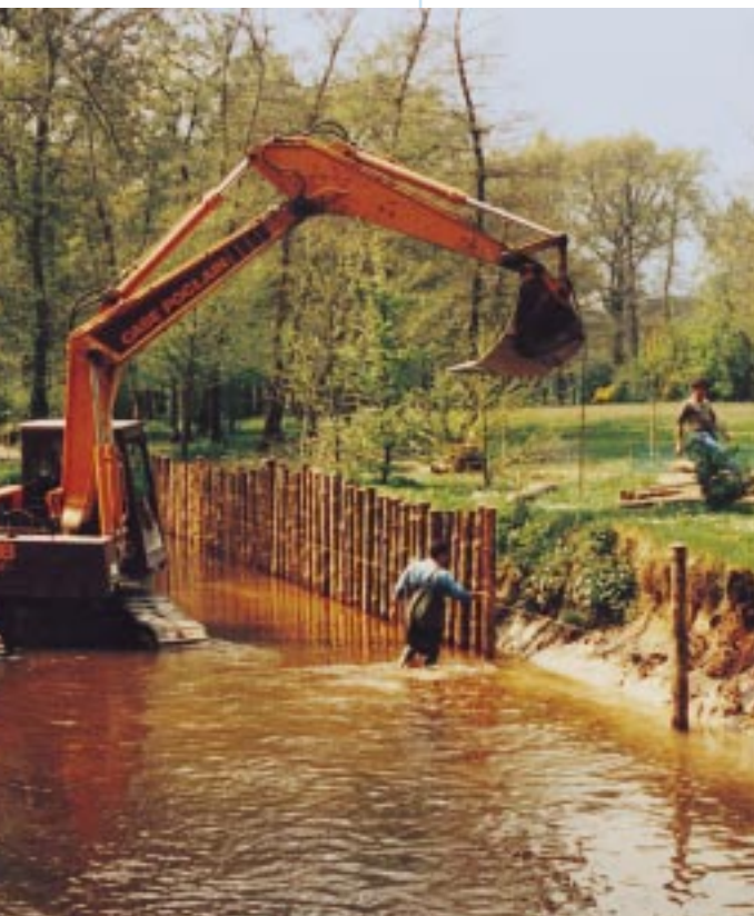
Travaux de stabilisation de berges par tunage.
