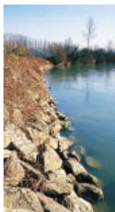
Protection de berges par enrochement.
