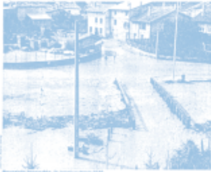
Bozouls (Ardèche) : la rue est envahie par les eaux.
