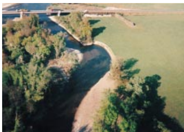
Ici la présence d'une route est un enjeu fort mais l'aléa d'érosion est faible : non urgence.
