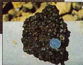
Détail du revêtement poreux.
