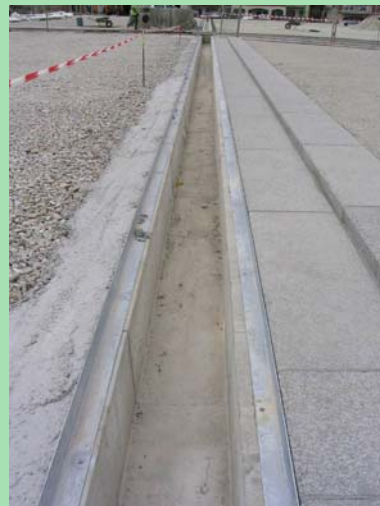
Caniveau de collecte des eaux de ruissellement avec drain d'injection dans la structure réservoir.
