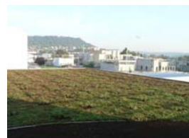
Toiture terrasse végétalisée
