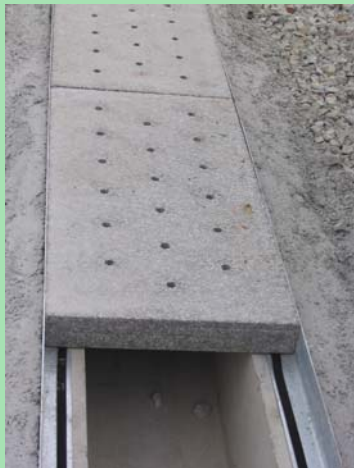
Dalles granit percées recouvrant le caniveau.
