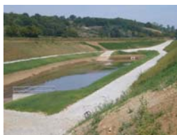
Bassin de retenue/infiltration
