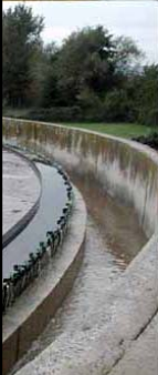
Cuve de récupération et rétention avec débit régulé
