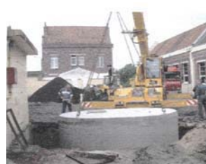
Cuve en béton enterrée
