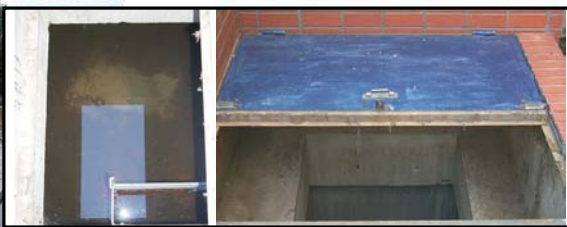
Bassin de décantation [en béton] situé en amont de la bâche de stockage enterrée
