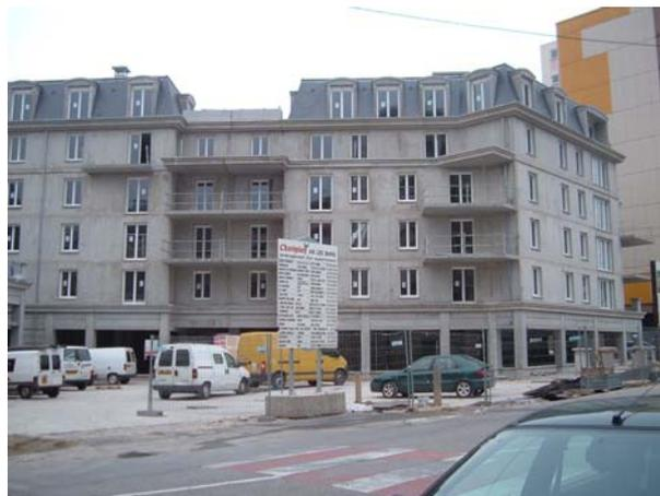
**CARACTERISTIQUES** : Surface imperméabilisée: 4900m<sup>2</sup>, volume de rétention: 175m<sup>3</sup>, dans garage du deuxième sous sol, évacuation par pompes.
