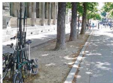
Tranchée continue avec bordure, Paris 4 e
