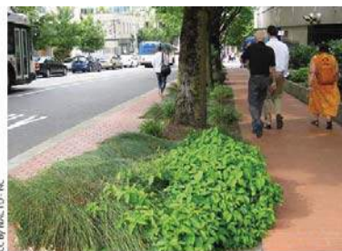
Tranchée continue recueillant les eaux pluviales, Portland
