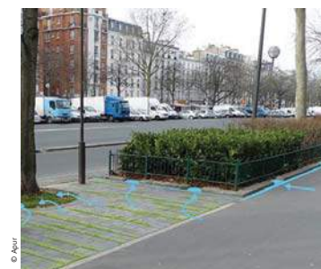
Reprise de bordures, nivellement et pavés engazonnés, Paris, photomontage
