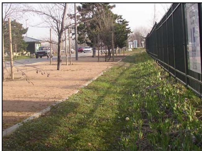
Noue de stockage et d'infiltration des eaux de voirie et de protection du lotissement contre le ruissellement agricole.
