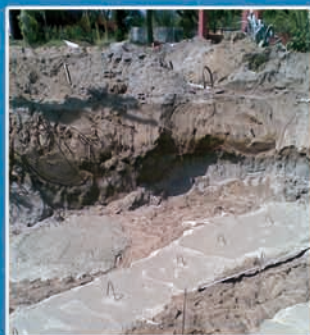
POSE D'UNE DALLE EN BÉTON POUR STABILISER L'OUVRAGE
