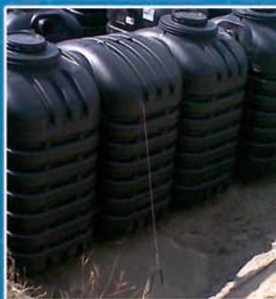
LES CUVES SONT FIXÉES AFIN D'ÉVITER TOUT MOUVEMENT
