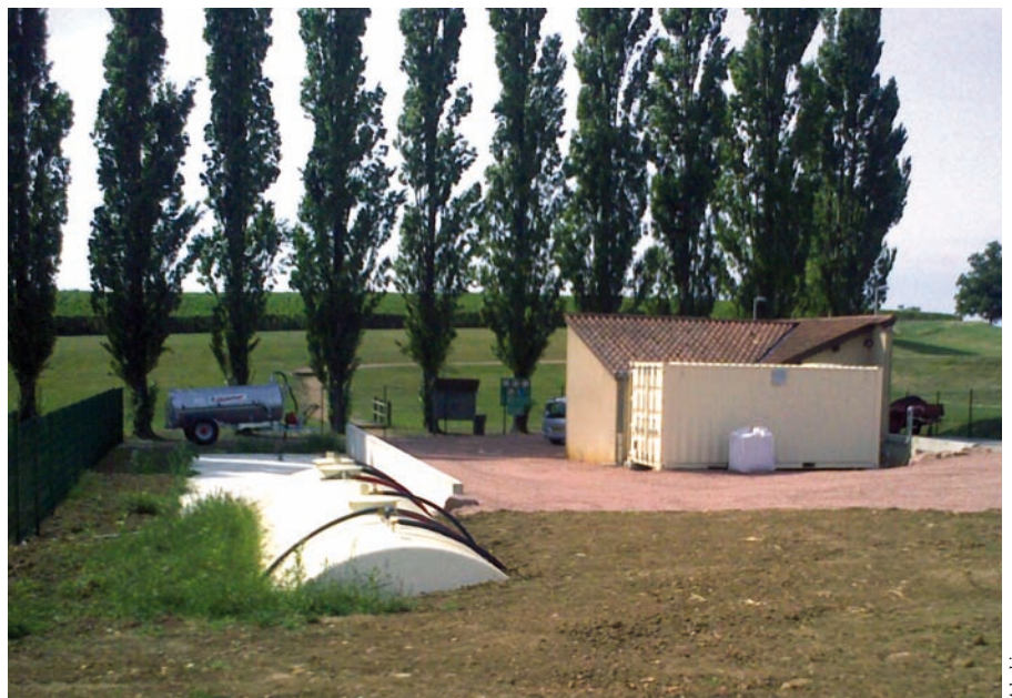
Station Mixte STRB1 & STRB2 pour le traitement des effluents vinicoles et phytosanitaires de la CUMA de Chaintré.
