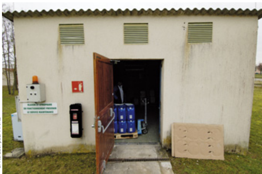
Local de stockage central extérieur.
