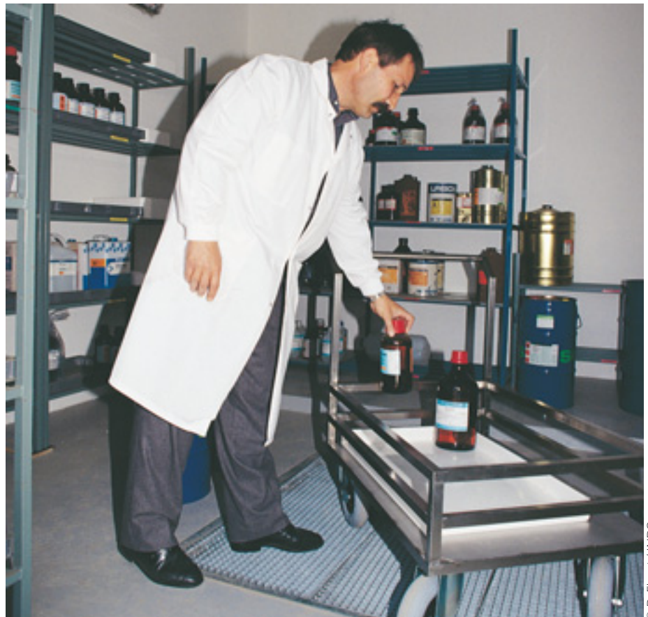
Intérieur d'un stockage central; remarquer les bacs de rétention sur les étagères, la rétention centrale, le chariot de manutention avec bac de rétention.
