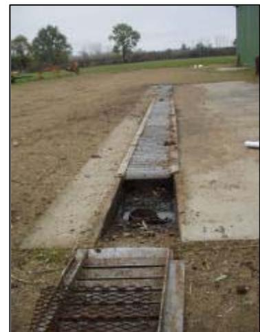
Le caniveau est un parallélépipède coffré de 35 cm x 35 cm de la longueur de l'aire, couvert d'une grille avec des cornières pouvant supporter le passage des pneumatiques. Ce caniveau sert de pré-décanteur (*cf outils de traitement*) et est curé à la pelle 2 fois par an. Le trop plein d'eau est évacué par un tuyau de diamètre 200 vers le système de traitement. Les débris grossiers sont poussés contre un muret dans le coin droit de l'aire avec un rabot monté sur le transpalette de l'atelier.
