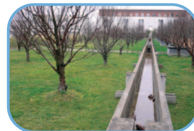
St-Jacques (35) : le toit du supermarché accueille un jardin-verger et un réseau superficiel majeur d'eau pluviale.
