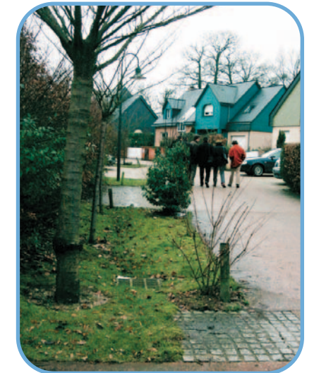
Bois Guillaume (76) : la noue peu profonde recueille les eaux de la voirie étroite en dalle de béton.
