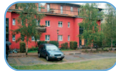
Berlin (All.) : pavés, dalles, "ever green" et voies étroites pour une infiltration maximale des eaux de voirie de desserte locale et de parking.
