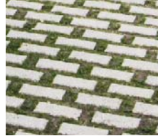
Pavage en béton avec ouvertures de drainage
