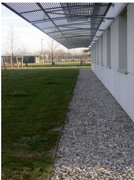
◀ Tranchée sous toit
