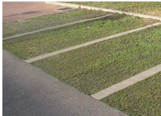
Exemple de places de parking enherbées non étanches et de revêtements poreux
