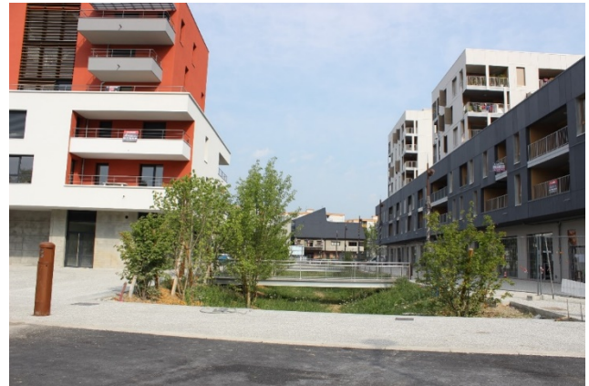
Gestion des eaux pluviales intégrée dans l'aménagement – La Ravoire
