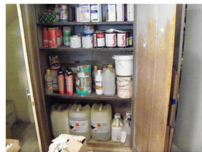
Stockage non conforme et non sécurisé de bidons et pots de peinture, de bidons d'acide chlorhydrique, d'acide fluoridrique, etc.
