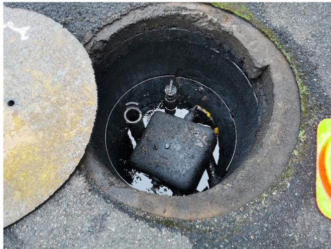
Figure 6 Photographie d'une cuve de récupération d'huiles noires d'un garagiste avec suspicion de débordement -
