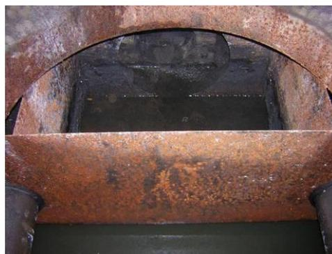
Exemple d'un séparateur d'hydrocarbures mis en place il y a moins de 4 ans et ne respectant pas les différentes étapes de fabrications (grenailage et revêtement répondant aux exigences de la norme NF EN 858-1)
