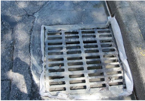
Protection des grilles EP avec de la toile géotextile « bidime » (Source : Chambéry Métropole)
