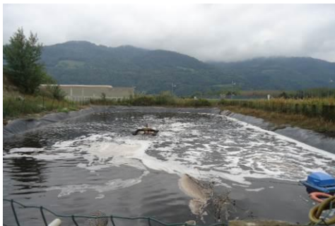
Lagune de 2 200 m 3 avec 3 oloïdes (1 central en surface et deux sur les côtés) mise en place sur le site de FERTISERE à Villard Bonnot (38) (Source : Grenoble Alpes Métropole)
