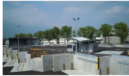
Déchèterie de Bissy (73) (Source : Chambéry Métropole)
