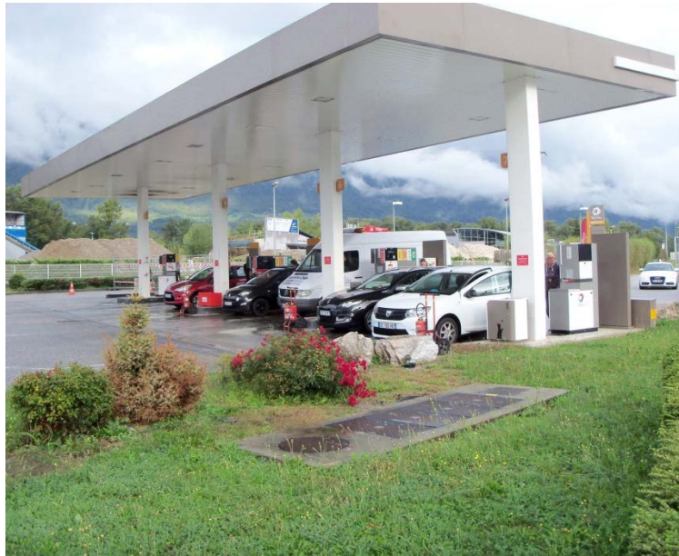
Aire de distribution de carburant.
