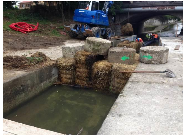
Les ballots de paille comme dispositif épuratoire (Source : CAVB, 2014)
