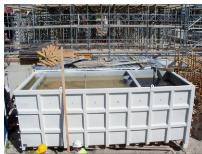
Schéma et exemples de décanteurs horizontaux Photo à gauche « un chantier dans le canton de Genève », à droite « un chantier à Chambéry Métropole » – (Source : Chambéry Métropole)
