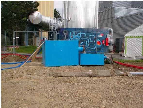
Un bac de décantation sous-dimensionné et donc inefficace (les eaux ne sont pas claires) (Source : Chambéry Métropole)
