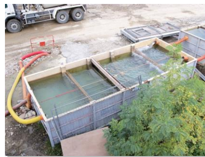
Schéma et exemples de décanteurs horizontaux Photo à gauche « un chantier dans le canton de Genève », à droite « un chantier à Chambéry Métropole » – (Source : Chambéry Métropole)
