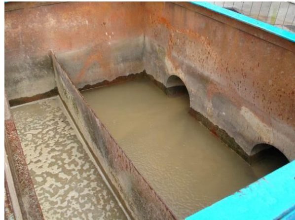
Un bac de décantation sous-dimensionné et donc inefficace (les eaux ne sont pas claires) (Source : Chambéry Métropole)
