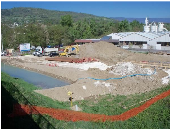
Chantier à Saint-Badolph : décantation dans un trou naturel sur site avant rejet au milieu (Source : Chambéry Métropole)
