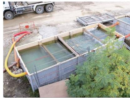
**Schéma et exemples de décanteurs horizontaux**
