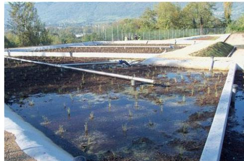
**Traitement par Filtre planté de roseaux** mis en place à la Plateforme de Champlat (73) (Source : Chambéry Métropole)
