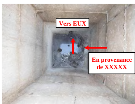
Figure 7 : Vues de l'intérieur du regard EU4
