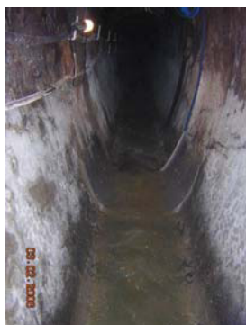
Capteur de type Hauteur/vitesse placé dans le collecteur du boulevard à l'amont du Déversoir d'Orage « DO_GAMBETTA »
