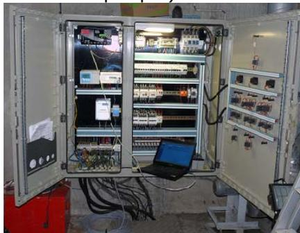
**Illust. 1:** Équipements de mesure et de télégestion d'une station de pompage, Ville de Mâcon
