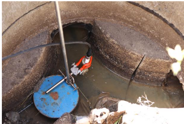
Figure 2 : Exemple d'installation d'un conductimètre in-situ lors de réalisation d'un traçage au sel (Graie -OTHU-TU Delft)
