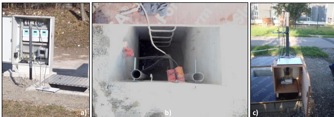
Illustr. 1: Exemple d'installation In situ (a –b) et d'utilisation d'une chambre de vérification déportée (c) (Chambéry métropole)
