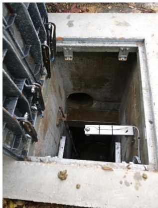
Illust. 4: Équipement d'un trop plein, Ville de Mâcon
