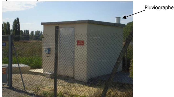
Illust. 4: Exemple d'installation d'un Pluviographe à augets basculants installé au niveau d'un poste de relèvement (Photo SIARP, Portes les Valence)
