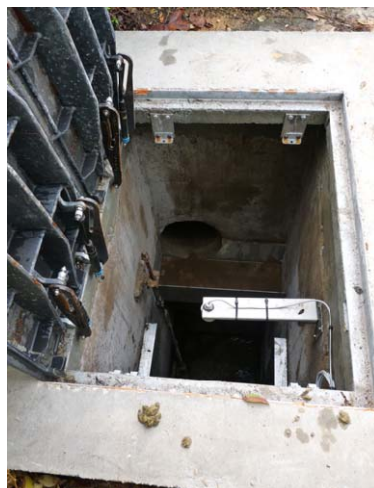
Illust. 5: Équipement d'un trop plein, Ville de Mâcon
