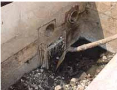
amont de la fosse de dépotage ou de réception des matières de vidange. Elle doit être nettoyée périodiquement par le personnel d'exploitation. On distingue le panier muni d'une grille suspendue au dessus de la fosse de réception, la grille manuelle intégrée à la fosse et le canal de grille pour les grosses installations.
