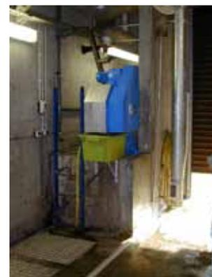
Photo 8 : Dégrilleur automatique type Aquagard de la station de Vienne
