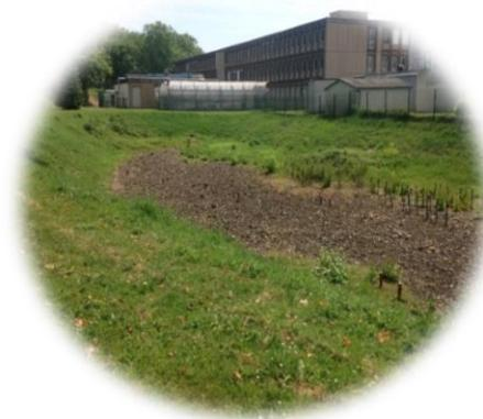
**Figure 8 : Noue sur le campus (à gauche) (Source : Cofrade C.)**
